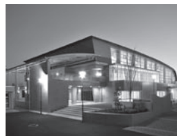
建築工事作品例
