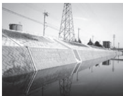
八田川味美護岸工事
