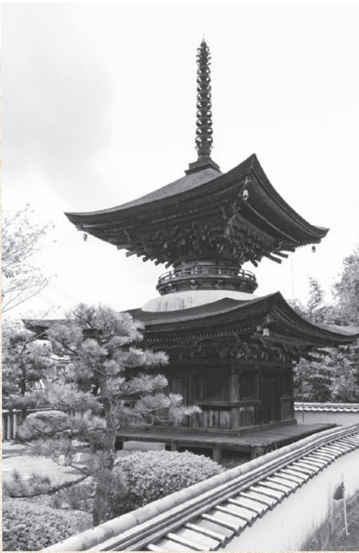
1535(天文4)年、松平清康公が建立した「多宝塔」。 境内唯一の室町時代の遺構である。
